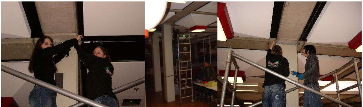
Halteseile für die Deckenstores werden auf Maß gefertigt, montiert und gespannt.
